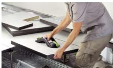
Двойной вакуумный держатель очень помогает при укладке ламинированных панелей регулируемых полов в офисах.
