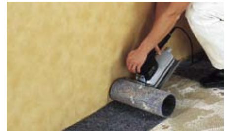
Машинка для удаления ковровых покрытий незаменима и при обработке углов.
