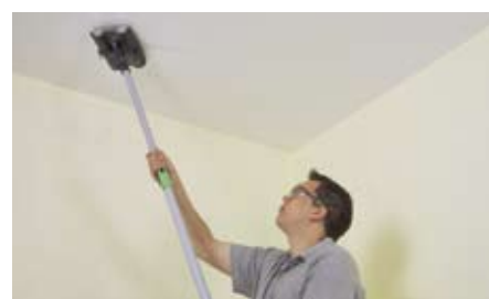
Благодаря телескопической ручке работа в помещениях с высокими потолками не представляет проблем.
