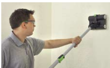
Регулировка глубины защищает грунтовое покрытие от повреждений.
