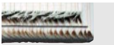
Поверхность со следами горения.
