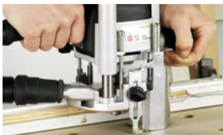
Удаление осколков стекол и замазки, например, при ремонте под новые стекла.
